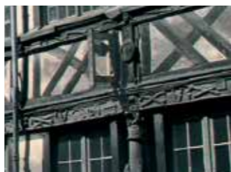
Le portant de bois de la cloche (aile Nord)
