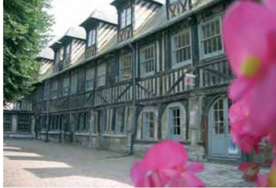
Vue du bâtiment Sud
